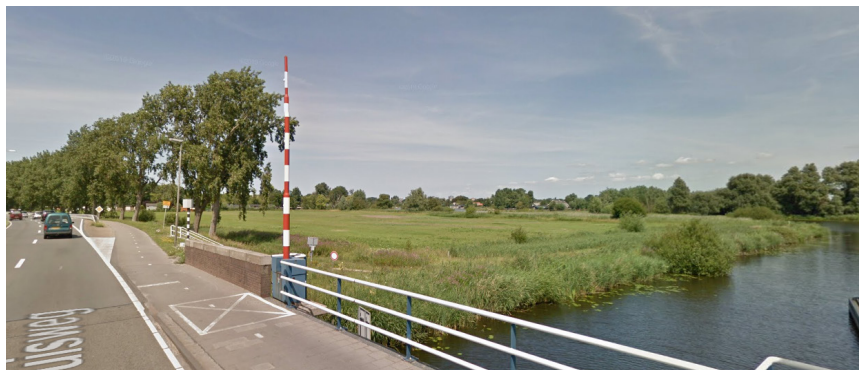
Afbeelding 2.16 Zicht op het gemaal in de richting van het afwateringskanaal (4)
