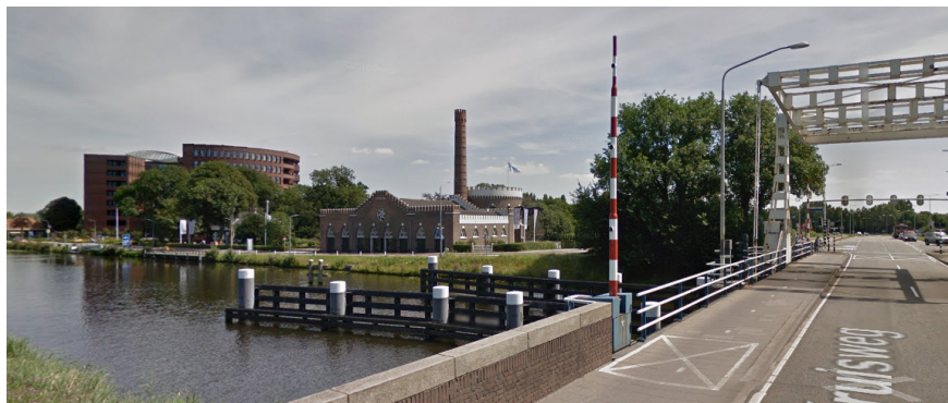
Afbeelding 2.15 Zicht in de richting van de Ringvaart in westelijke richting (3)
