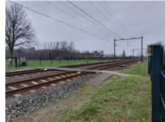
Overgang spoorweg met hekwerk
