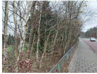
Hekwerk naast voetpad N208
