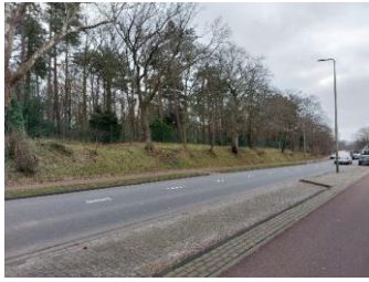
Hekwerk langs wandelbos en N208
