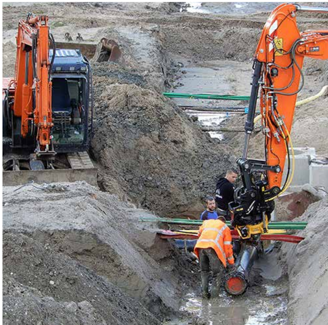
Aanleg van de riolering tijdens de bouw van de stadse woonwijk Hyde Park in Hoofddorp.
