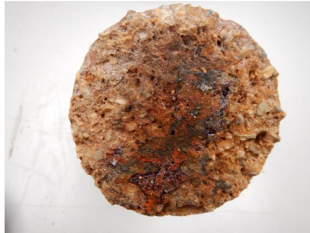
Afbeelding 3: Onderzijde ASR1, roestproduct zichtbaar.
