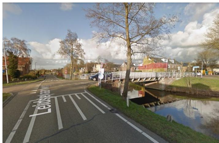
Situatie vanuit Leidsevaartweg (zuidzijde brug)
