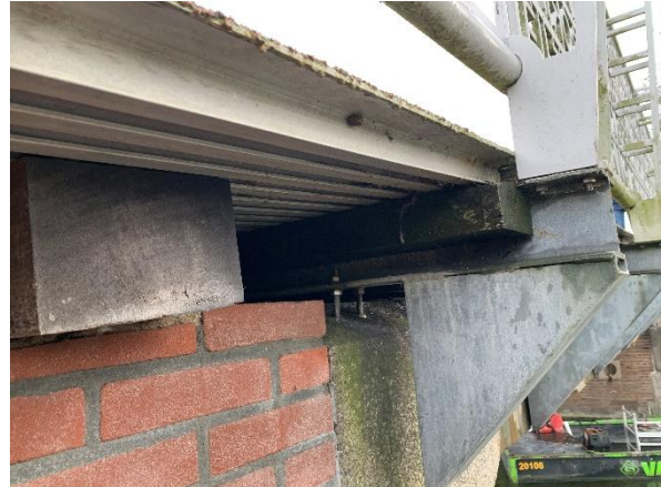
Foto 2.4: Oplegging voetpad en leuningconstructie
