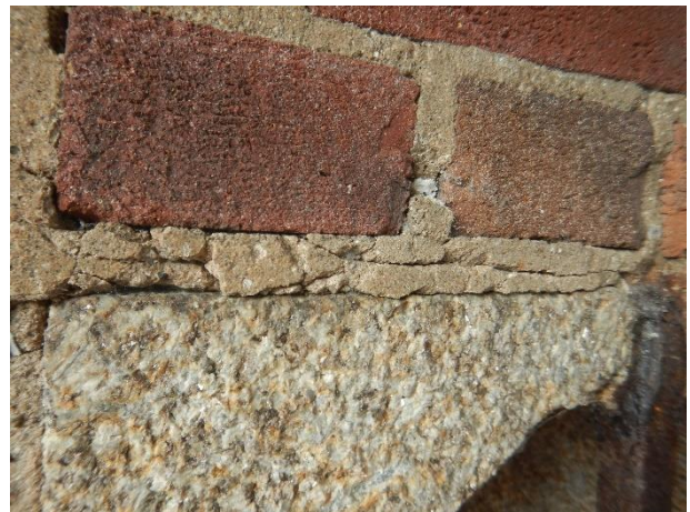
Foto 4.13: Voegwerk beschadigd
