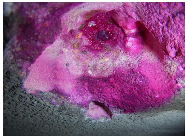
Foto 5.4: Onderzoekslocatie C2, reparatie niet gecarbonateerd, daarachter wel
