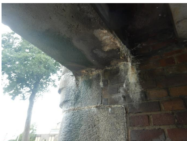
Foto 4.3: Leksporen ter plaatse van oude hwa-doorvoeren
