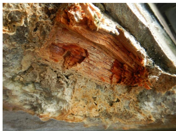
Foto 4.4: Stuk hout in reparatie
