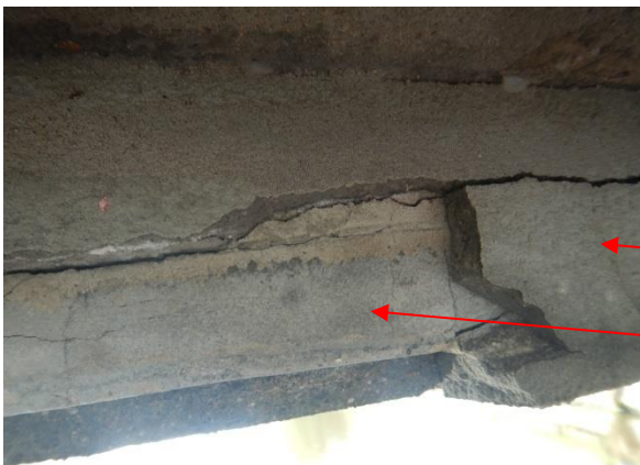
Foto 2.5: Reparatielaag op onderzijde brugdek
