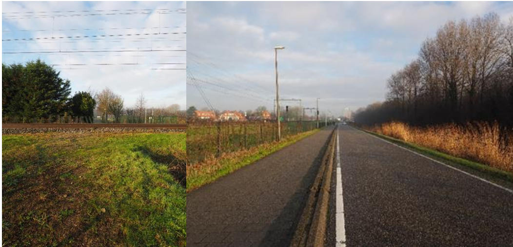
Figuur B3-1 Doodlopende populierenrij langs de Leidsevaartweg en het ontbreken van een veilige passage van de Leidsevaartweg (mede door de opstaande rand tussen fietspad en weg)
