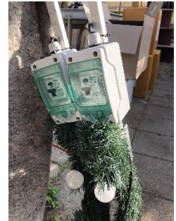
Figuur 1 Aanbrengen aardlekschakelaar
