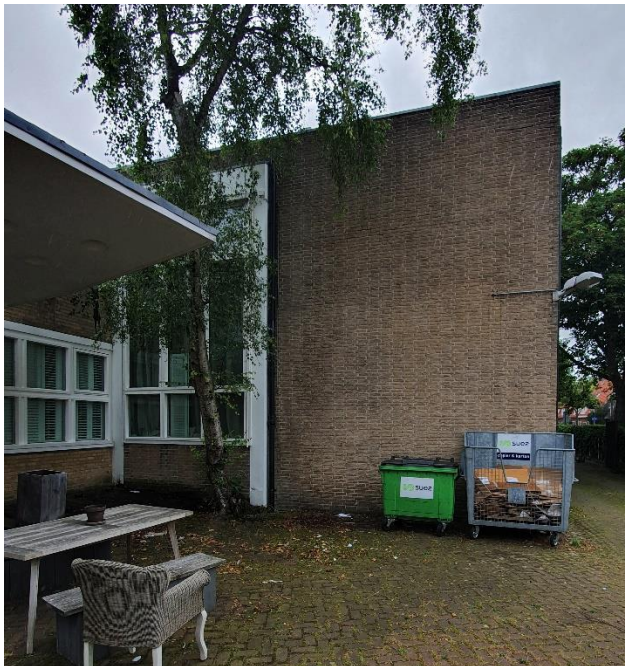
17. Achtergevel van het voorste bouwdeel.
