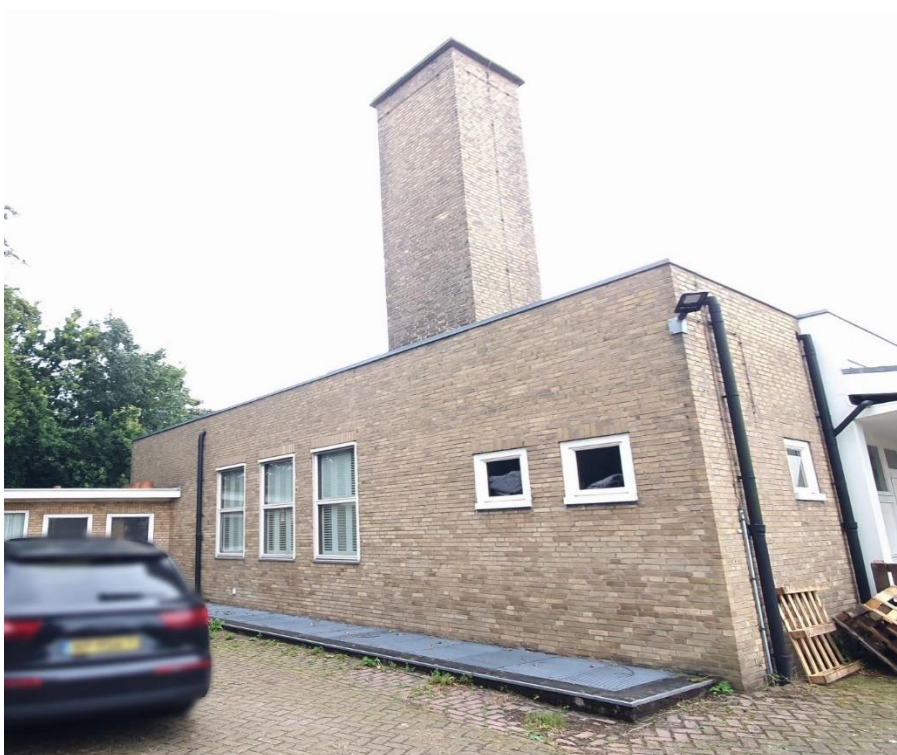
14. Achteregevel van achterste bouwdeel.
