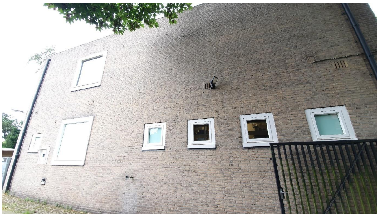
18. Linkerzijgevel van het voorste bouwdeel.
