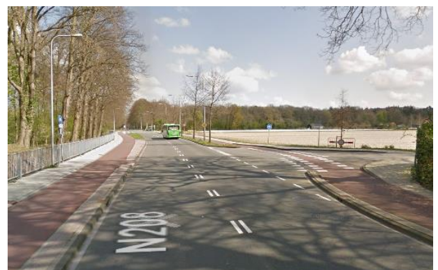
Figuur 4: oversteekplaats zonder kanalisatiemarkering
