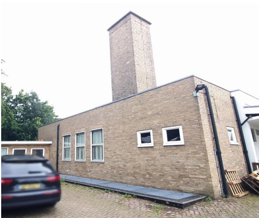
14. Achteregevel van achterste bouwdeel.
