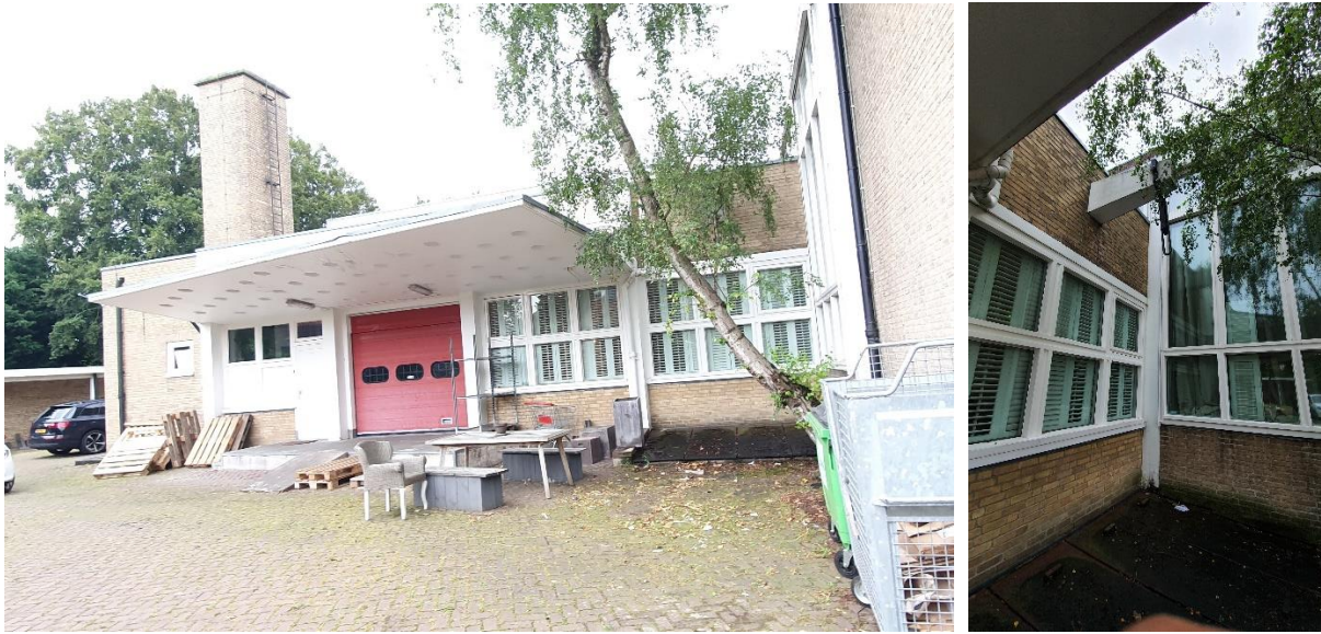
15. en 16. Linkerzijgevel met personeelentree. Rechts, detail met hijsbalk.
