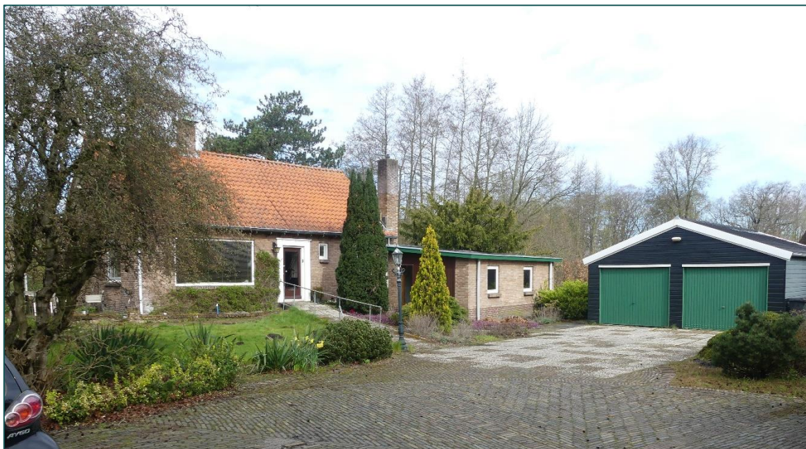
Figuur 1.1 De planlocatie is gelegen aan de Duin en Vaart 12 te Heemstede.
