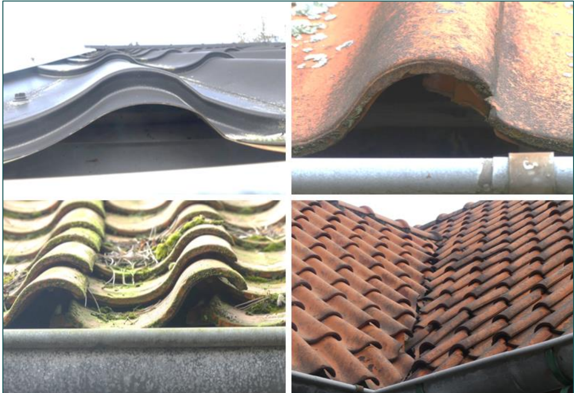
Figuur 3.2 Impressie van openingen in de te slopen woning en garage die voor huismussen kunnen dienen als (potentiële) nestlocaties.
