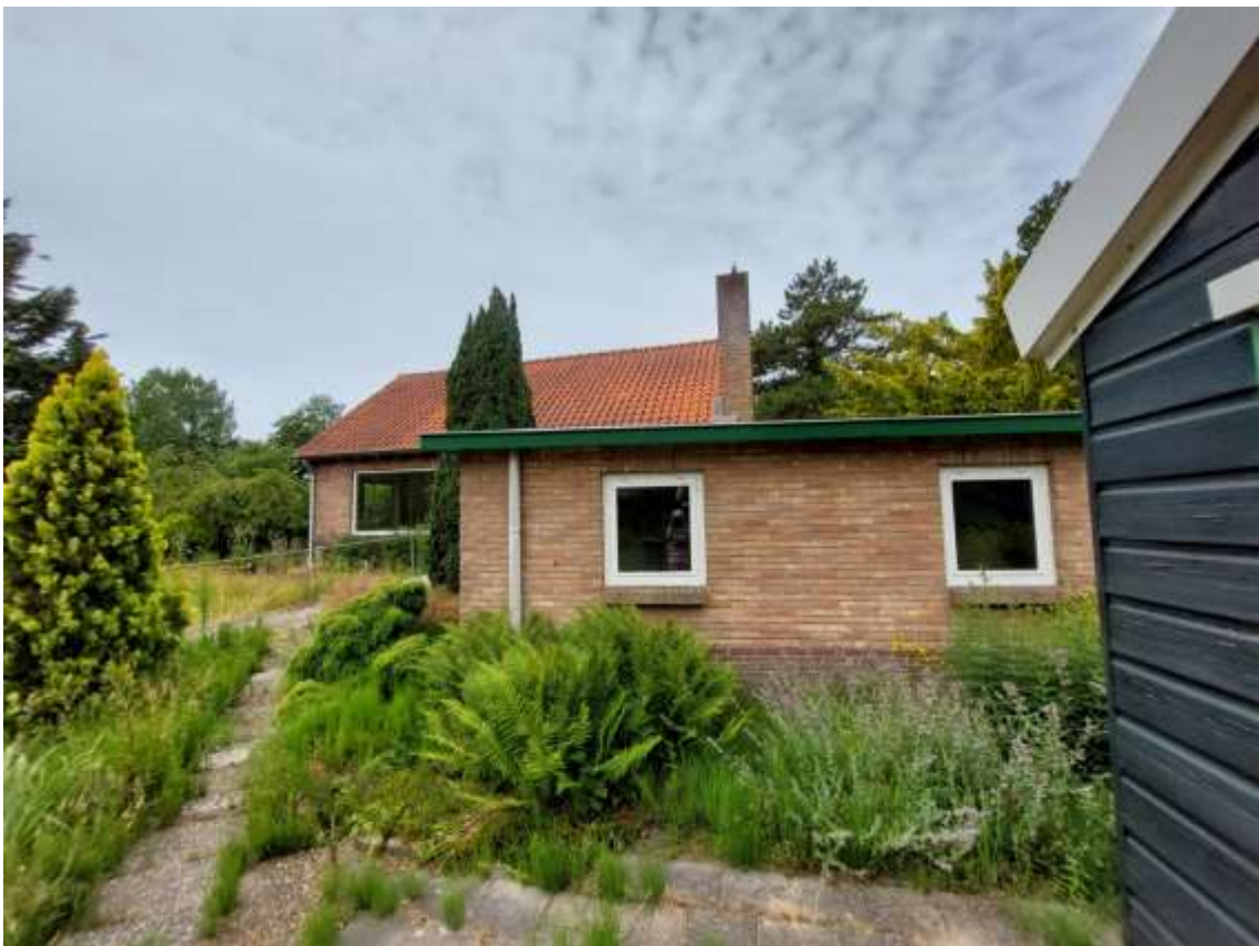
Figuur 24: Oostgevel van Duin en Vaart 12, naar W gezien. Uiterst rechts de deur van de garage. Foto: 27 juni 2023.
