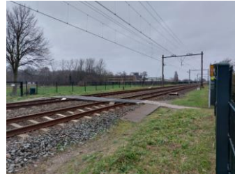
Overgang spoorweg met hekwerk
