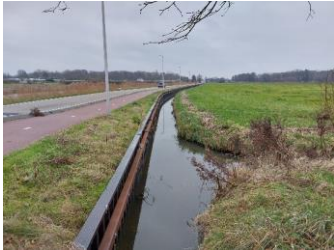
Harde steile kadewand naast fietspad
