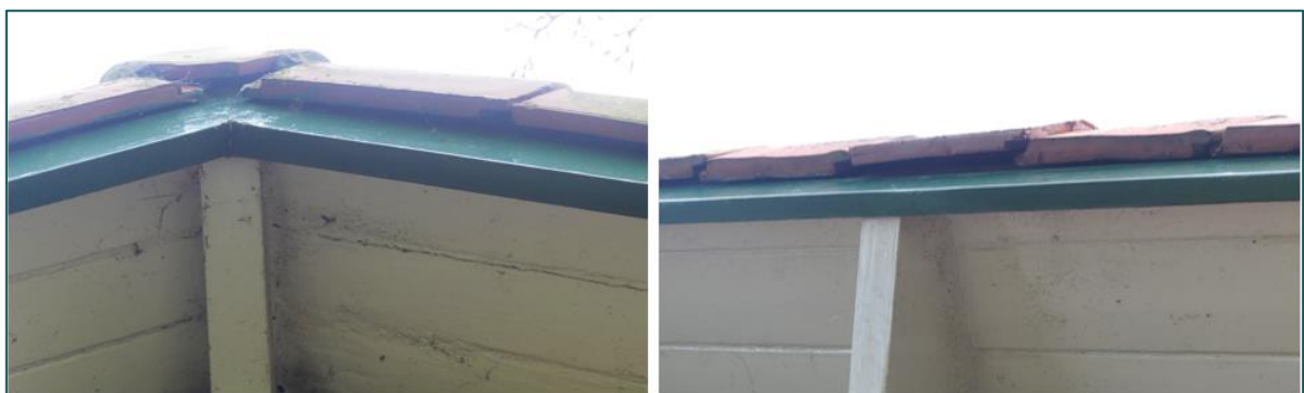
Figuur 3.3 Impressie van openingen in de te slopen woning en garage die voor huismussen kunnen dienen als (potentiële) nestlocaties.
