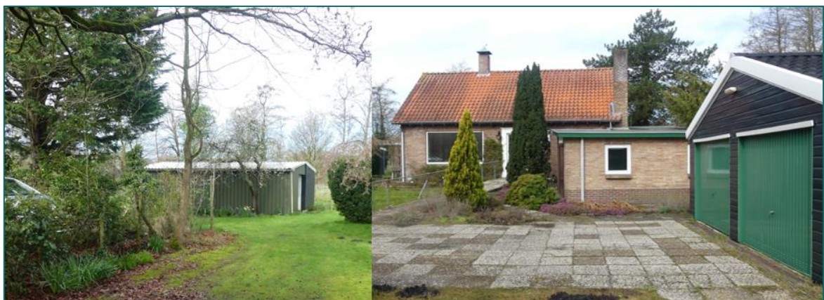
Figuur 1.3 Op de planlocatie is men voornemens om de woning en garage (rechts) en de schuur (links) te slopen.
