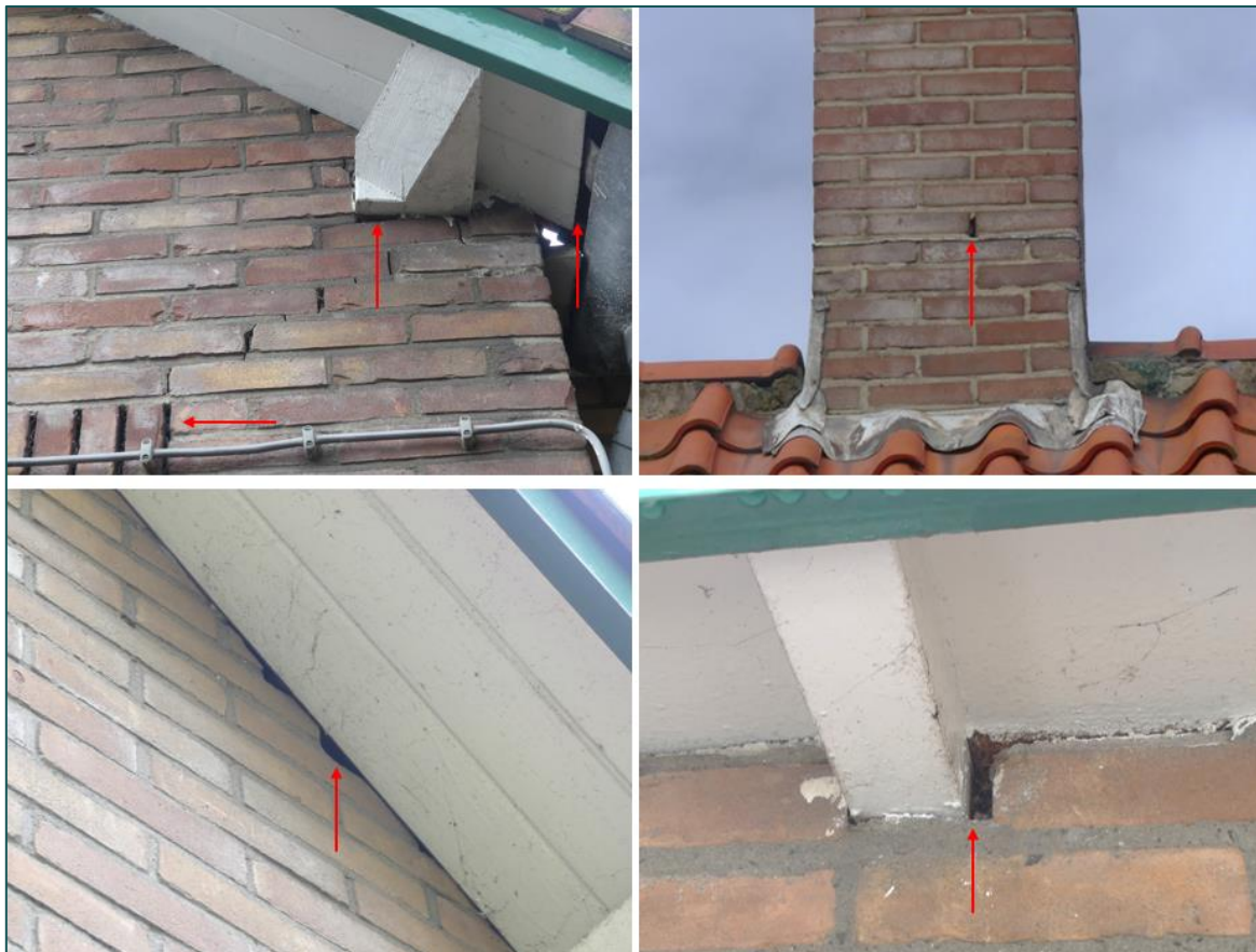
Figuur 3.1 Impressie van potentiële invliegopeningen voor vleermuizen in de te slopen woning.
