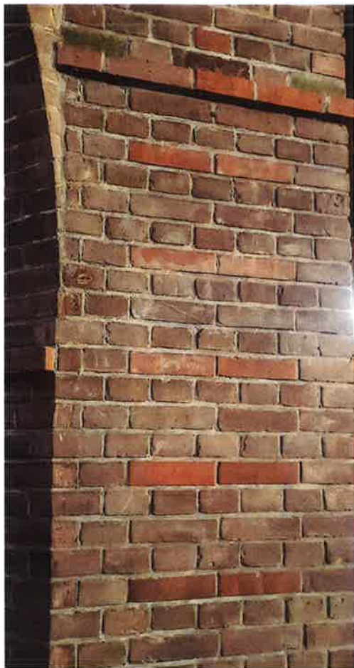
Afb. 16. Het muurwerk van de noordwestelijke pijler. Foto auteurs.
