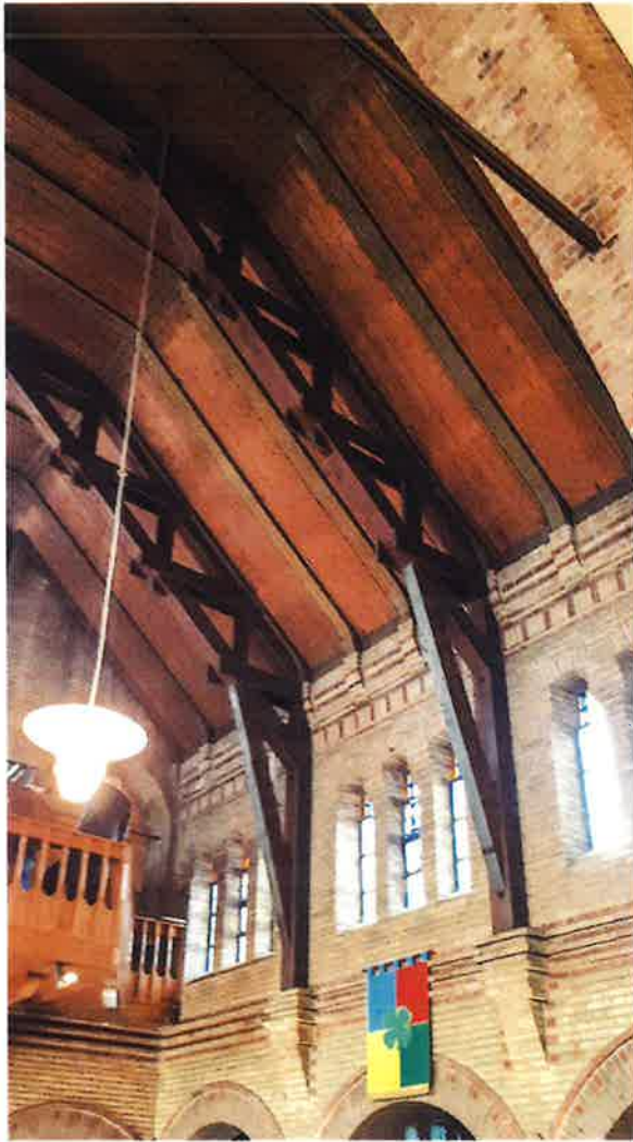
Afb. 28. De houten vakwerkgebinten in het schip. Foto auteurs.
