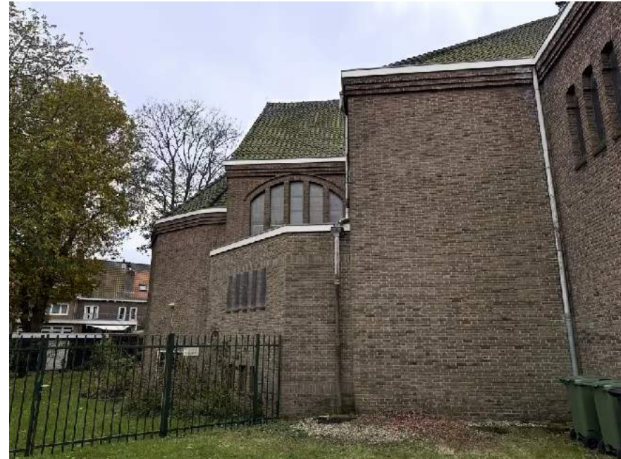
Noordelijke zijde van het koor. Het metselwerk geeft een gemêleerde indruk vanwege de toepassing van gesinterde (donkerkleurige) bakstenen. De kroonlijst van de gevel bestaat uit uitkragend gemetselde koppenlagen waartussen getrapt metselwerk.
