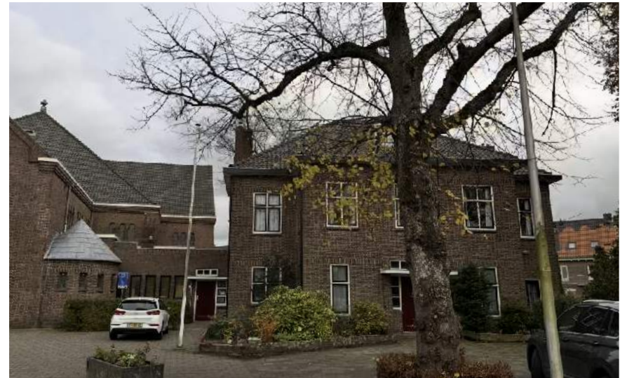
Aan de rechterzijde van de voorgevel bevindt zich een halfronde kapel waarachter de eenlaagse verbinding met de pastorie.
