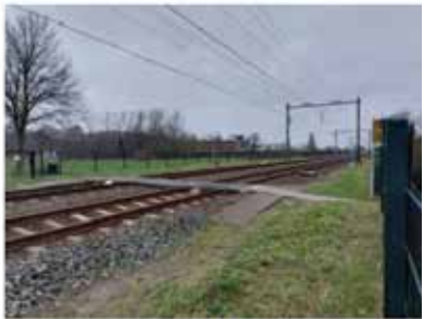
Overgang spoorweg met hekwerk
