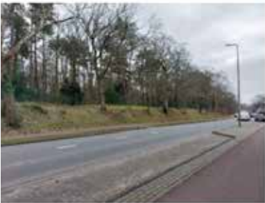
Hekwerk langs wandelbos en N208
