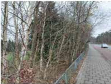
Hekwerk naast voetpad N208
