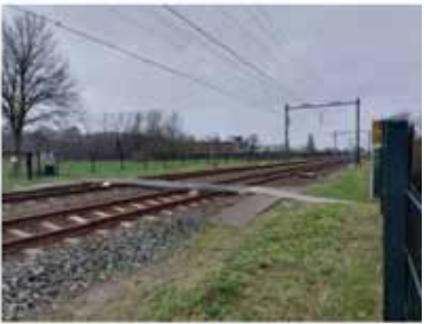
Overgang spoorweg met hekwerk
