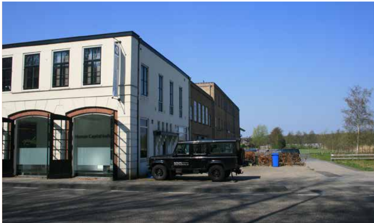
Kwaliteit van voormalige bollenschuur en rijksmonument aan de Herenweg
