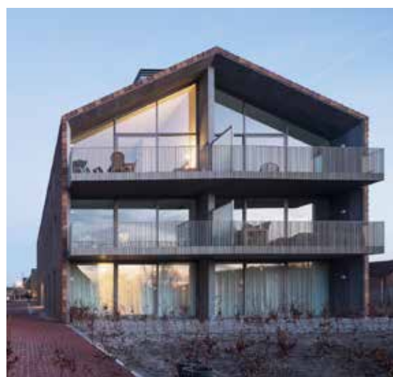
basisprincipe bouwvolume met kap als jasje
