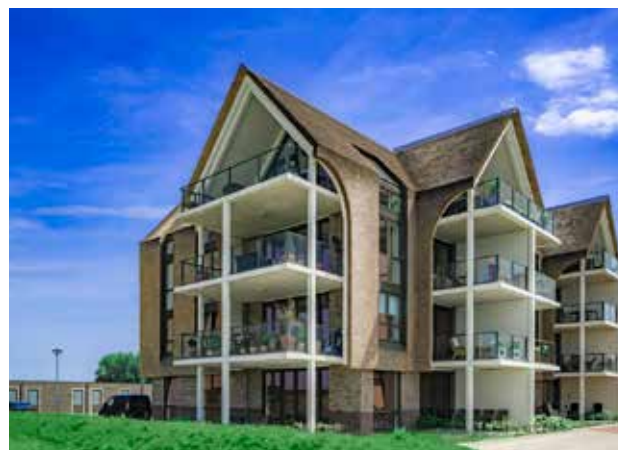
overstek kopse kant met balkons
