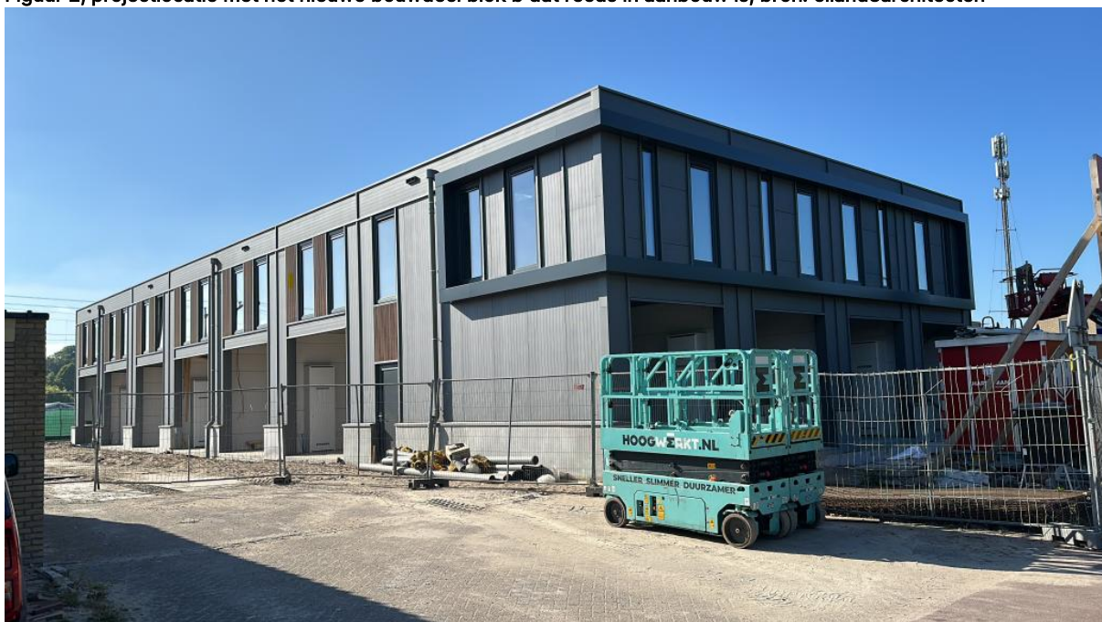
Figuur 2, projectlocatie met het nieuwe bouwdeel blok b dat reeds in aanbouw is, bron: eiland8architecten
