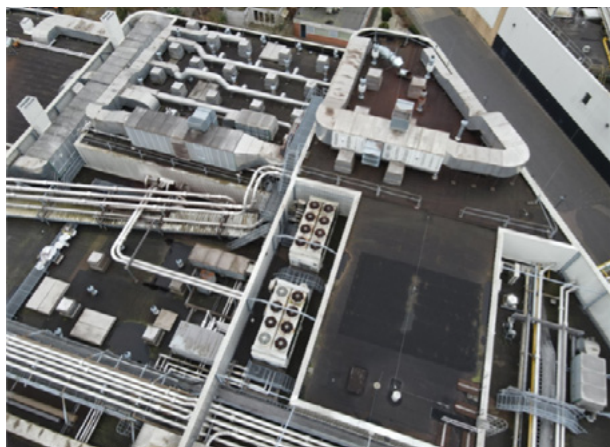
Toezicht Cargill vanuit de lucht
